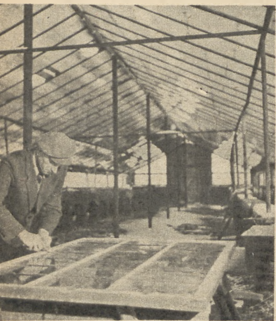
Spółdzielcy wykończają budynek cieplarni. Jeszcze trzeba wstawić ostatnie szyby i dach doprowadzić do porządku.
