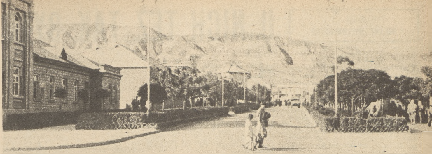
W pobliżu miejsca, gdzie rodzi się wielka zaporą, powstało nowe miasto Mingeczaur; wygodne domki, szerokie, asfaltowane ulice, dużo zieleni — oto, co cechuje nowe miasto. W Mingeczaur są już szkoły, kina, stadion, żłobek i przedszkola.
