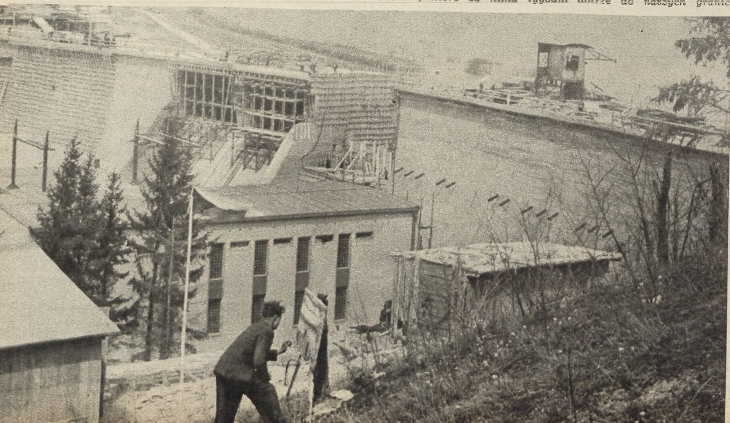
Zapora na rzece Orawie w Czechosłowacji — tuż nad granicą polską, jest częścią składową największej budowlie hydroelektrycznej w Europie Środkowej. Budowa zapory, dochodzącej do 30 metrów wysokości, pochłonięła 220.000 metrów sześciennych cementu. Ze spiętrzenia wód — powstaje „Morze Słowackie”, które za kilka tygodni dotrze do naszych granic.
