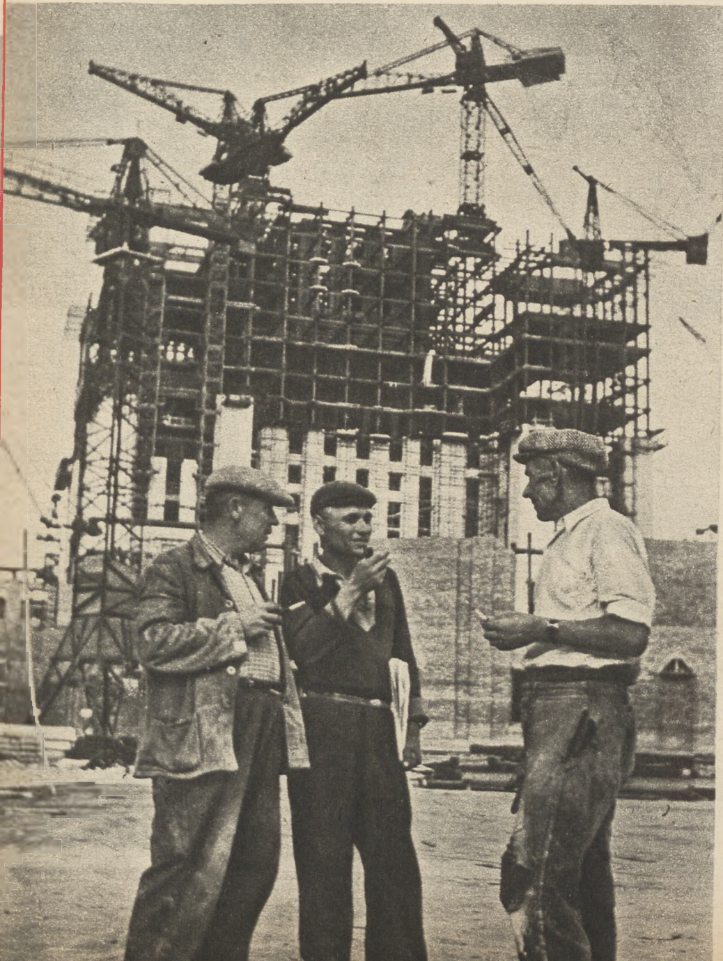
Na budowie Pałacu Kultury i Nauki. Po skończonej pracy Aleksy Stichajenko (w środku) z ożywieniem rozmawia z polskimi towarzyszami pracy.
