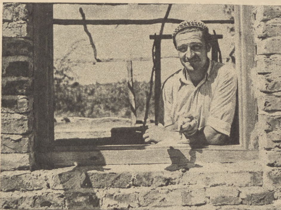
Nowy las i nowe domy w Aleksandrowie. Ten budynek stawia Kazimierz Osiński, doświadczony murarz, który pracował przedtem na niejednej warszawskiej budowie.
