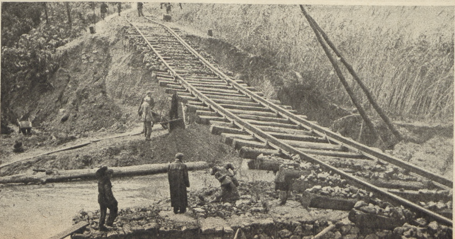
Most kolejowy łączący Reggio Calabria z Catanzaro został dosłownie wymyty przez falę. Setki zburzonych mostów, dziesiątki kilometrów rozmytych dróg i torów kolejowych, sto miliardów lirów strat — oto bilans zbrodniczej polityki chadeckiego rządu.
