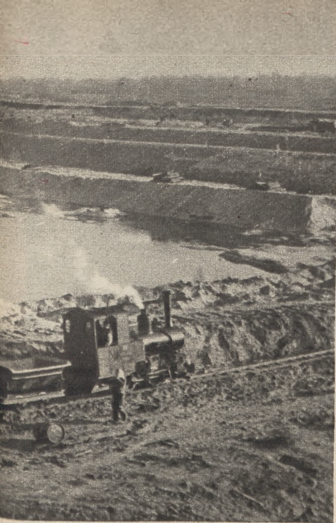
sypania przeciwpowodziowych wałów ochronnych, stanowiących zarazem ściany przyszłego zbiornika wody
