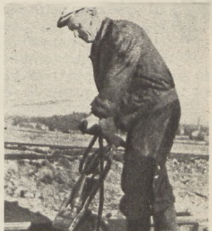
Dwa nowo prześia szyn łączą się żelaznymi tępakami.
