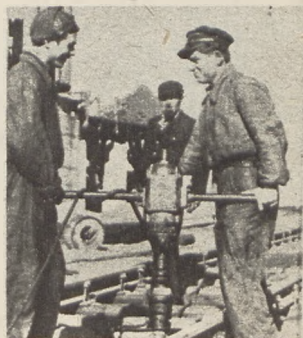
ZMP-owiec Benek za pomocą elektrycznego przyrządu podbija nowy tor.
