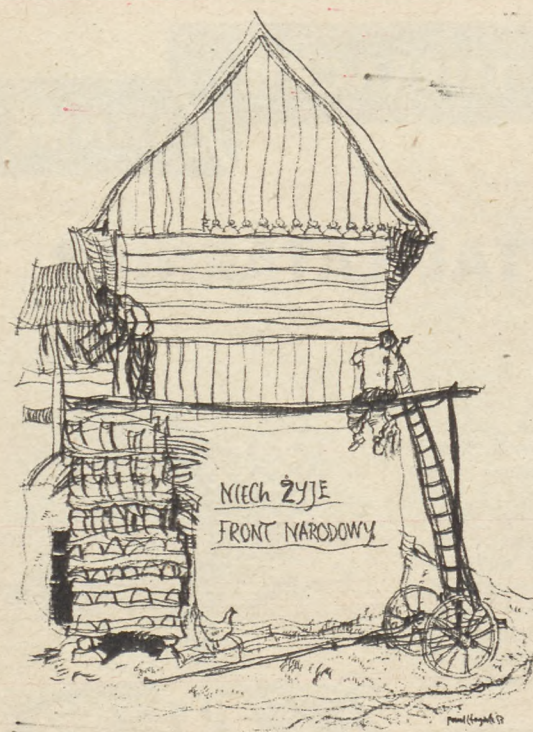
BUDOWA DOMU NA PODHALU.
