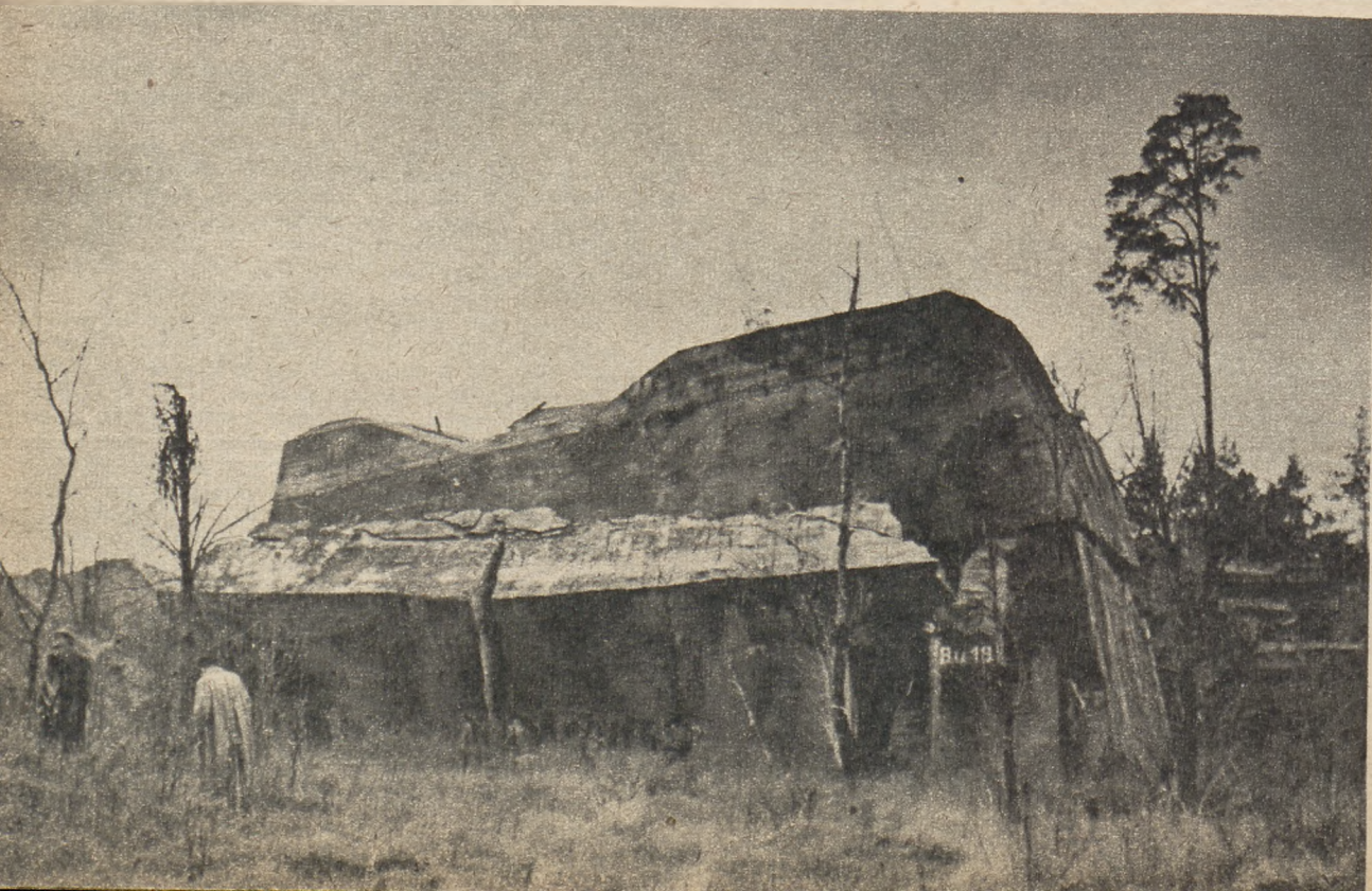
Rozbrojone ziemie dają swobodny dostęp do osobliwego obiektu, niegdyś rzadka tylko zwiedzanego przez turystów. Tysiące ton betonu i stali zużyto na budowę bunkrów, które chroniły „fuhrera” i generałów.
