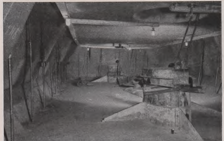
Bild 15. Hilfssenkkasten. Pfeiler XX.
