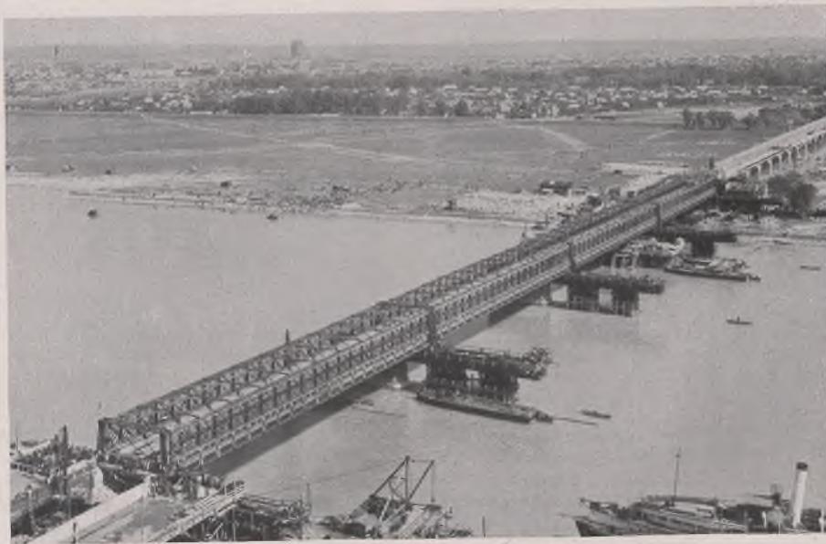
Bild 7. Ausschieben der alten Brücke.
