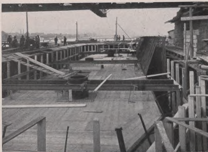
Bild 12. Senkkasten. Pfeiler XVIIa.
