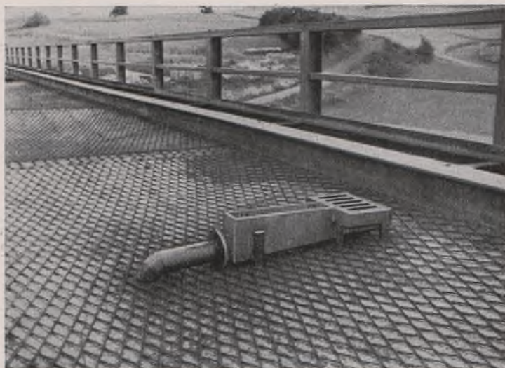
Bild 11. Oberflächeneinlauf und Streckmetallgeflecht in den Buckelblechen.
