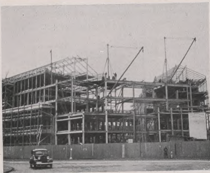
Bild 7. Aufstellung der Stahlkonstruktion am Fehrbelliner Platz. Dahinter die fertig aufgestellten Seitenflügel.
