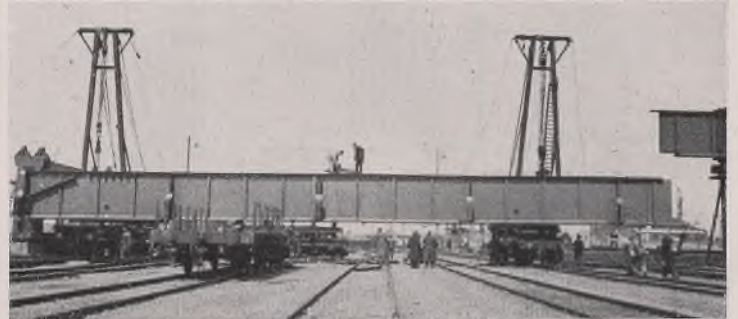
Bild 10. Aufstellung des Streckträgers D-E .
