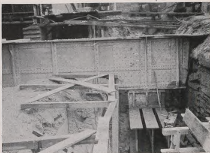
Bild 8. Kragträger, gestützt neben dem Untergrundbahntunnel in der Barstraße, zur Aufnahme der Stützen des vorspringenden Bauteils.
