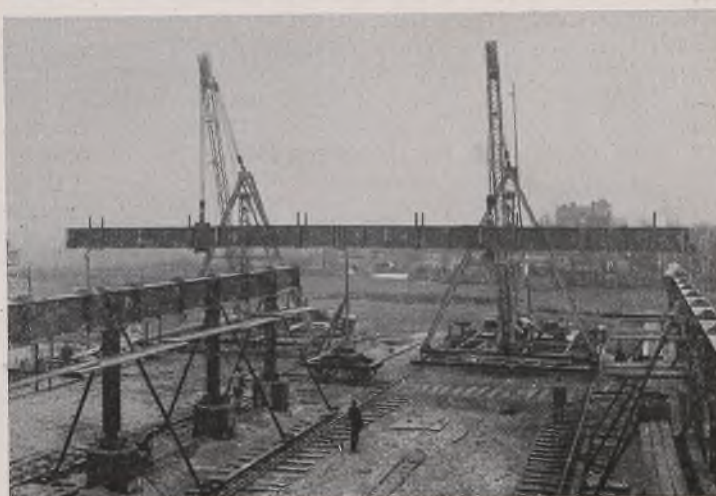
Bild 8. Aufstellung der Träger G-H-OL .
