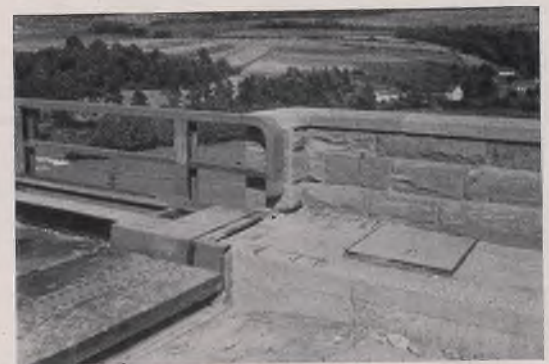
Bild 19. Anschluß des Geländers an die Flügel.
