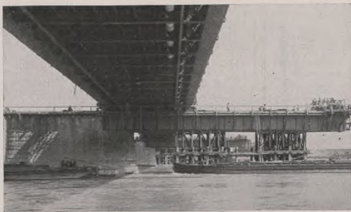
Bild 8. Ausschieben der alten Brücke.
