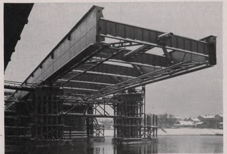
Bild 41. Einschieben des Versteifungsträgers der Mittelöffnung.
