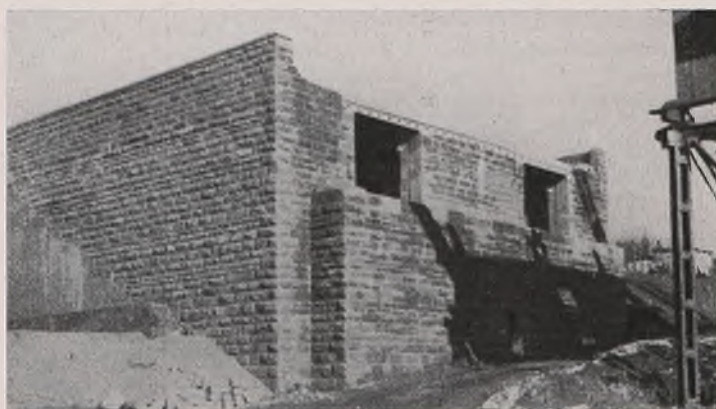
Bild 14. Kammern für die Besichtigungswagen im nördlichen Widerlager.
