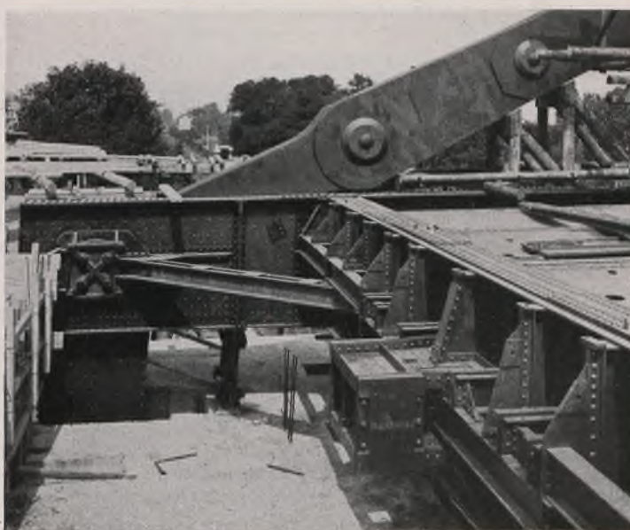
Bild 32. Rückhalte- und Ankerkette und Windwiderlager.
