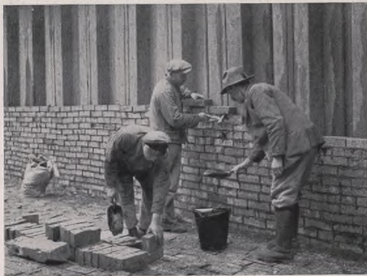
Bild 18. Ein Klinkertrog schützt das Fundament des Pfeilers 2.
