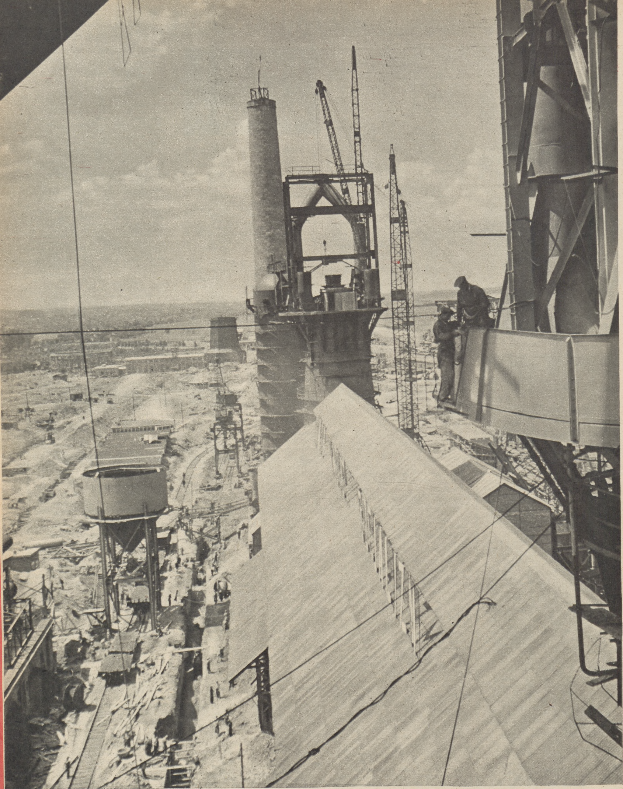
BUDOWA HUTY IM. BOLESŁAWA BIERUTA, JEDNEJ Z IMPONUJĄCYCH BUDOWLI PLANU 6-LETNIEGO
