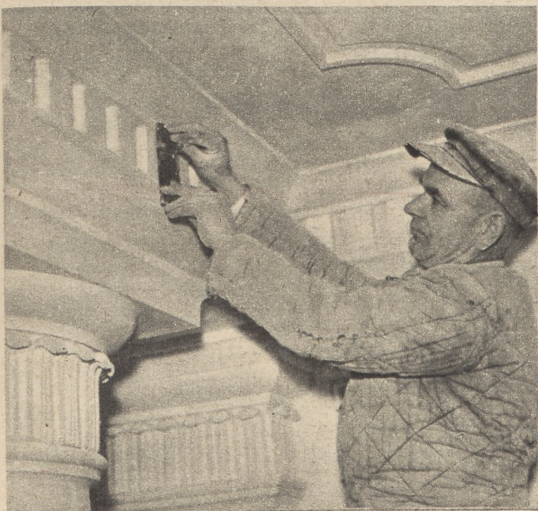
Bolesław Strych, lat 52 — murarz, jeden z przodujących budowniczych Muranowa.
