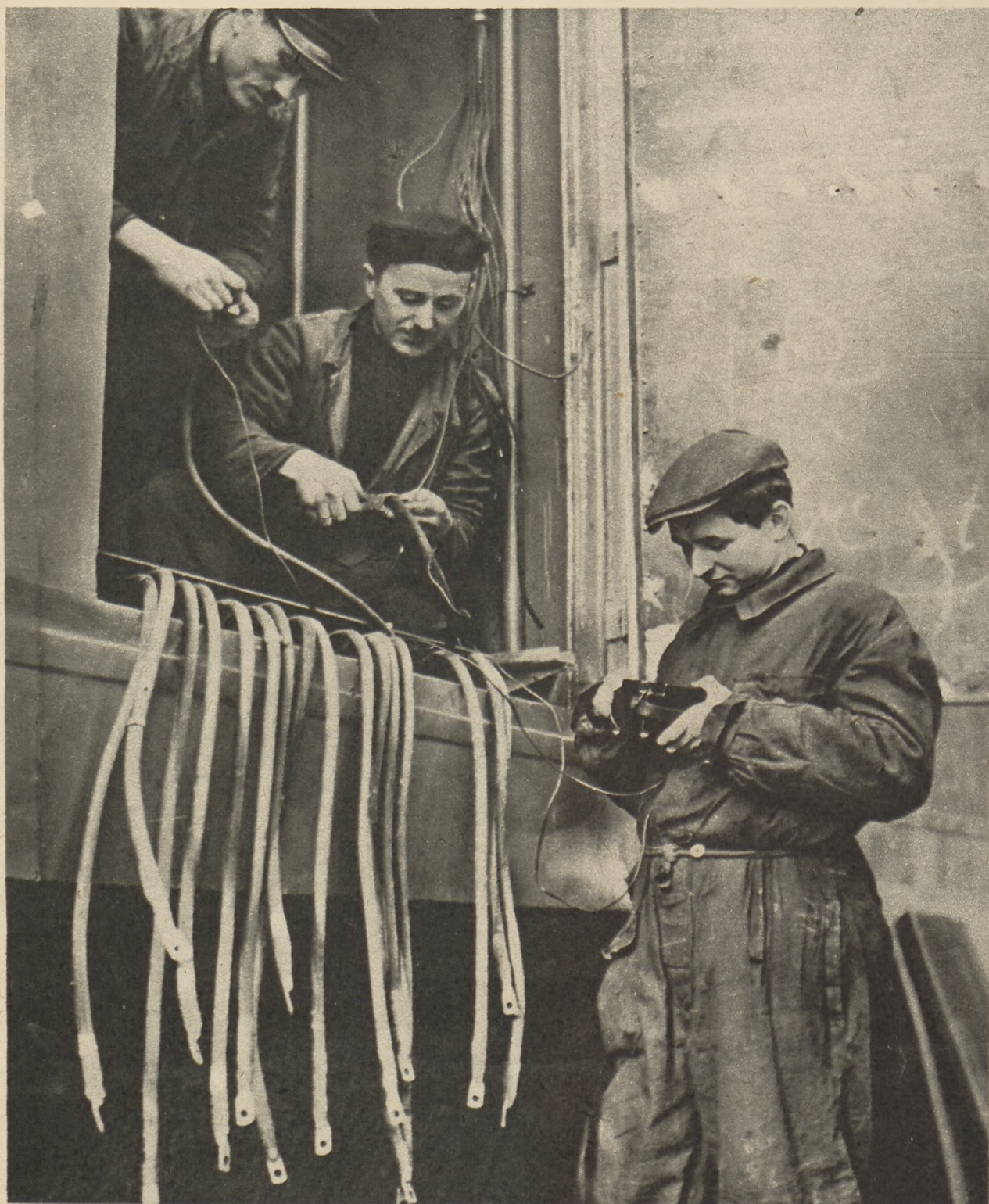
Racjonalizator Kwak (z prawej) z młodymi elektrotechnikami przy montowaniu silnika napędowego. Praca ta nie jest łatwa: silnik waży 4 000 kg i połączony jest siecią kilkuset przewodów z elektryczną instalacją elektrowozu
