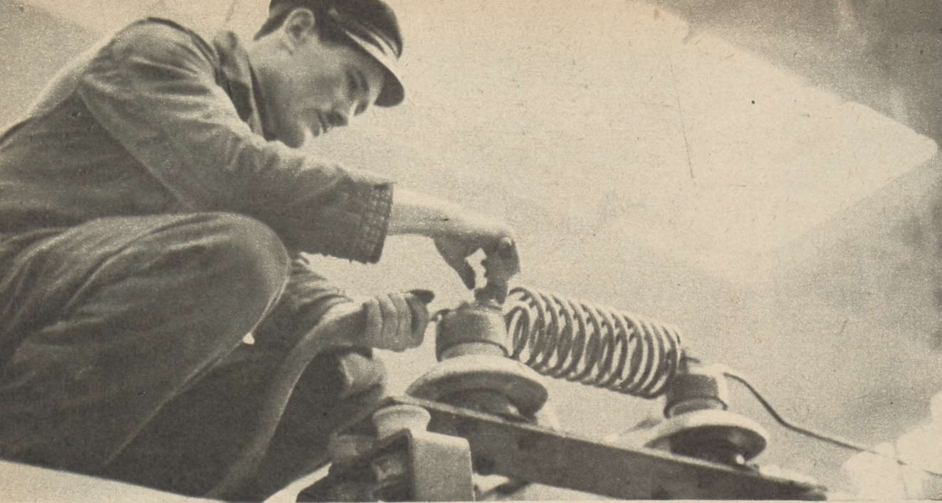
Instalowanie palaków na dachu wagonu. Będzie płynął przez nie prąd z przewodu wysokiego napięcia do silnika
