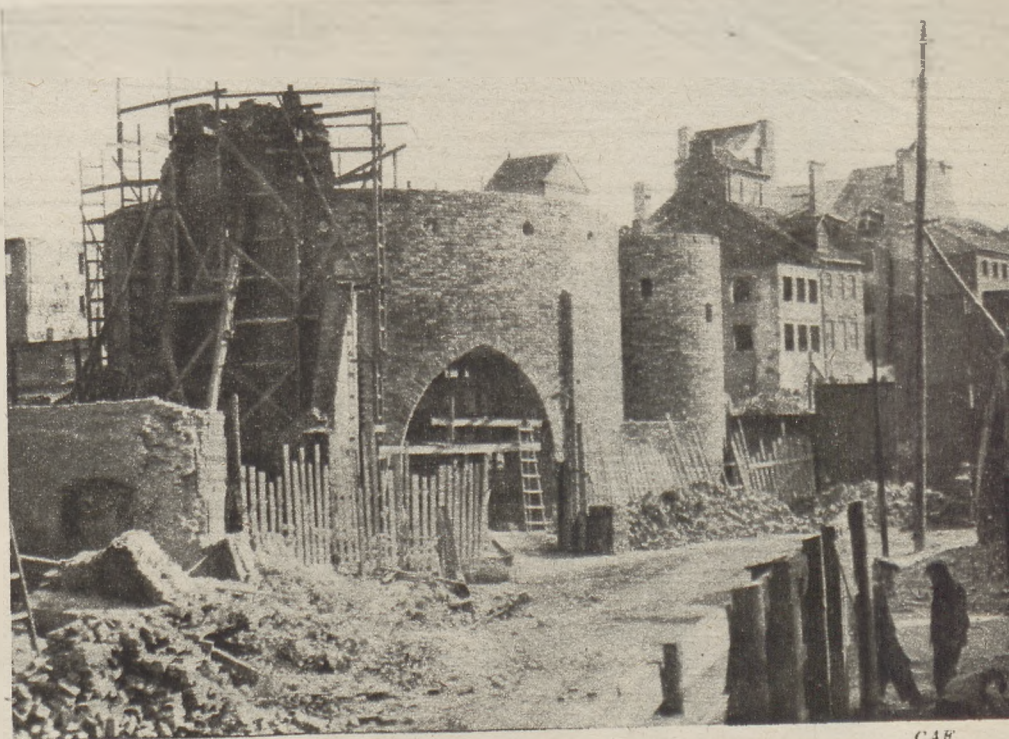
Na Starym Mieście budowniczowie Warszawy rekonstruuja bardzo pieczołowicie, według starych planów i sztychów, średniowieczny Barbakan oraz potężne mury obronne. Prace renowacyjne są już posunięte daleko naprzód
