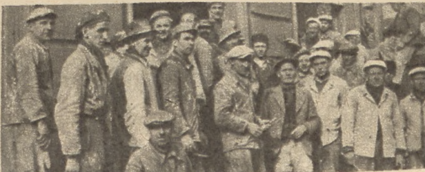
Brygada Spółdzielni Pracy Sztukatorów-Modelarzy i Posadzarzy w Stalinogrodzie, która wykonała fasadę nowego budynku
