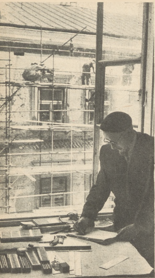
Malarz, którego widzimy w pracowni, z pewnością siedzi już na rusztowaniu malowanej przez niego kamienicy. Plastycy są już na budowie
