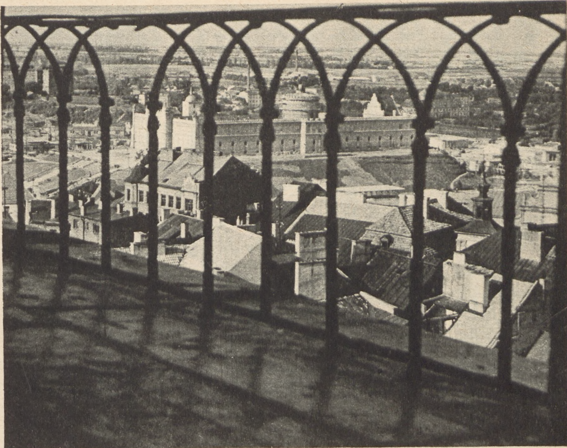
Widok na Stare Miasto i Zamek. Od marca do dnia dzisiejszego odremontowano na Starówce i w śródmieściu 10.000 izb. W przebudowie Lublina brało udział 15 tysięcy ochotników — mieszkańców miasta
