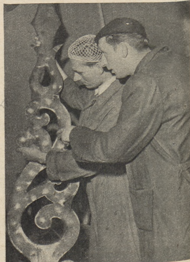
Marian Ogorzeja ukończył właśnie wykuwanie zegarowej wskazówki. Zanurzy ją jeszcze we wrzącym oleju...
