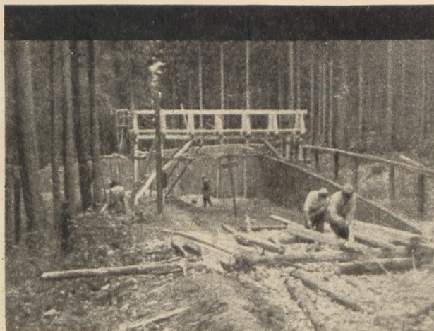
By uniknąć wypadków przebudowano most nad dużą bandą.
