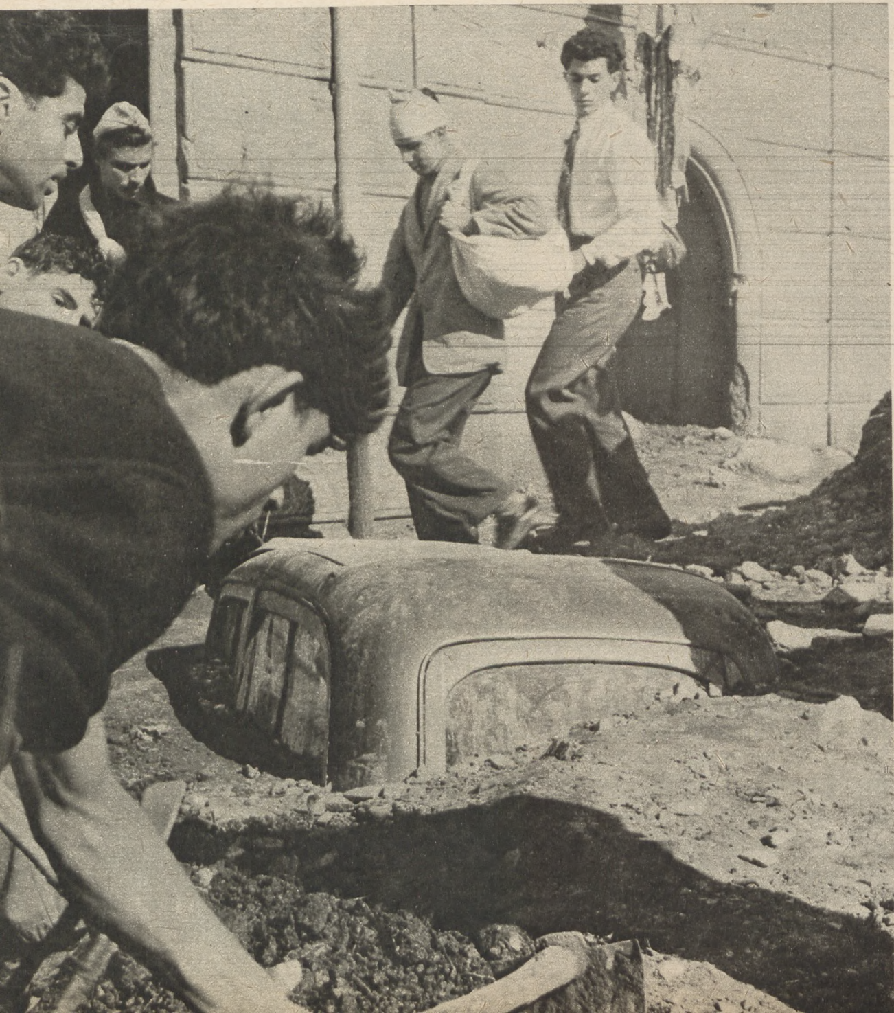
Do pracy nad oczyszczaniem ulic ruszyły brygady ochotnicze. Młodzi robotnicy z miejscowej huty szkła odkopują samochód niemal całkowicie zagrzebany w gęstym mule, naniesionym przez wylew rzeki.
