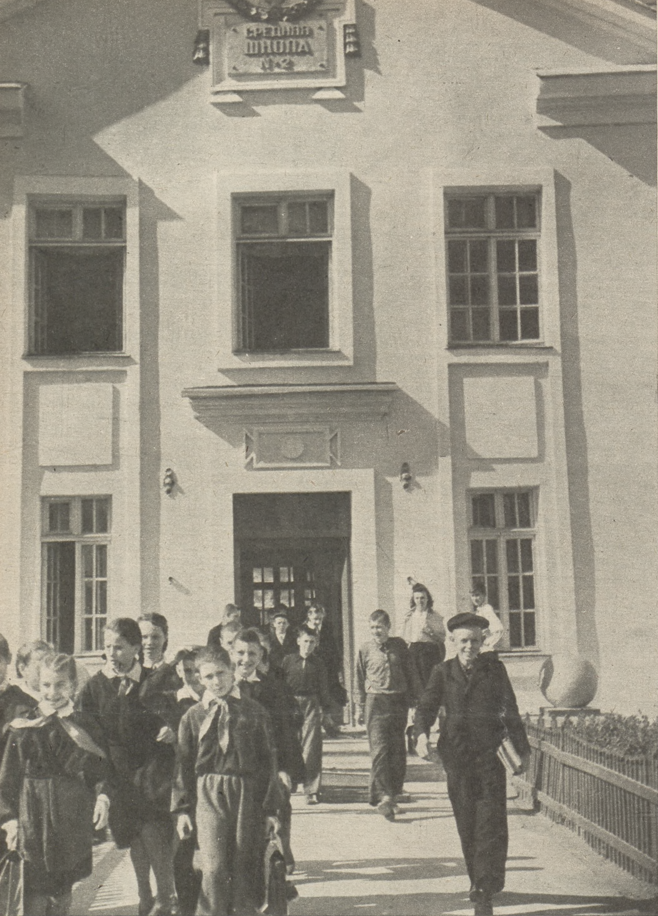
W Komsomolsku, osiedlu budowniczych elektrowni Kujbyszewskiej, uruchomiono ostatnio drugą szkołę średnią.
