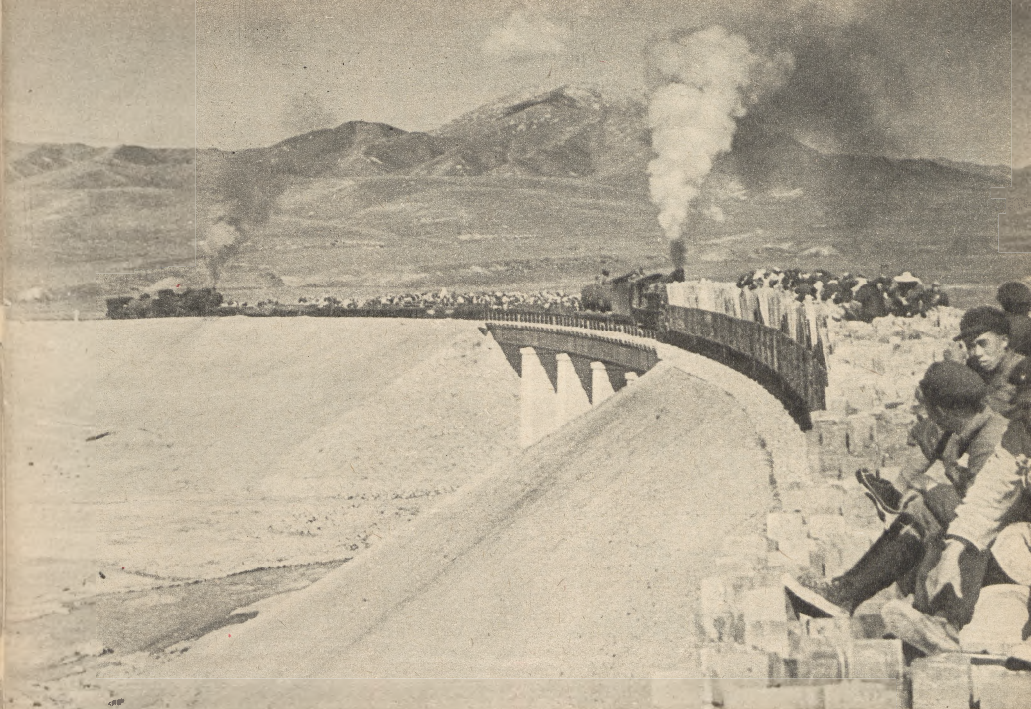
NA BUDOWĘ LINII KOLEJOWEJ ŁANCZOU — URUMCZI — ALMA-ATA PRZYBYWAJĄ NIEPRZERWANIE POCIĄGI Z ROBOTNIKAMI, SPRZĘTEM, BUDULCEM.
