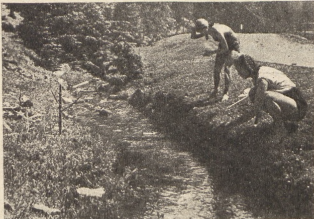
Renata Troll i Krystyna Gaweł dokonują pomiarów szybkości przepływu wody w Białej Wisłce. ...Potem badają profil koryta rzeczki.
