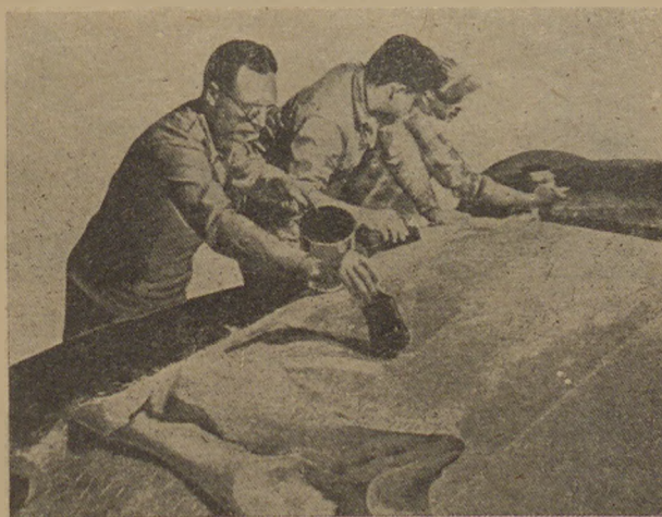
Rys. 2. Wykonywanie formy. Nakładanie tkanin i mat szklanych oraz żywicy.
