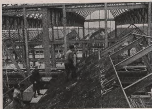
Bild 31. Aufbringen der Bimsbetondielen.
