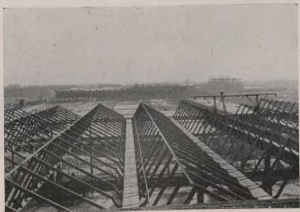
Bild 23. Die montierte Sägedachkonstruktion.
