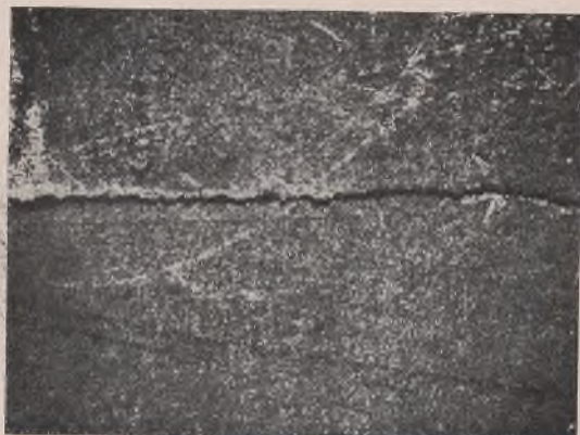
Bild 10. Bild eines Blechrisses infolge Dauerbeanspruchung.
