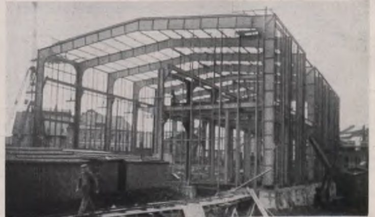
Bild 3. Stahlkonstruktion nach beendeter Aufstellung.
