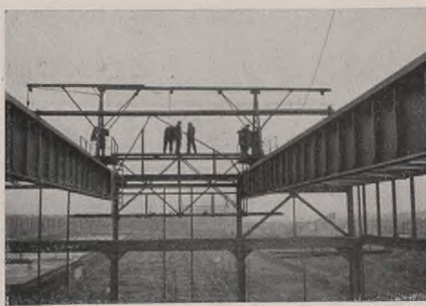
Bild 22. Gerät für den Einbau der Sägedachkonstruktion.
