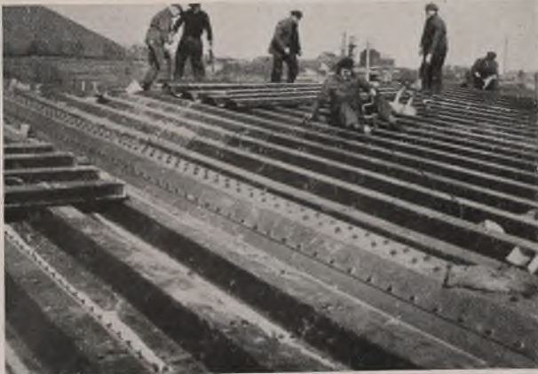
Bild 4. Dacheindeckung aus gekanteten Stahlblechen.
