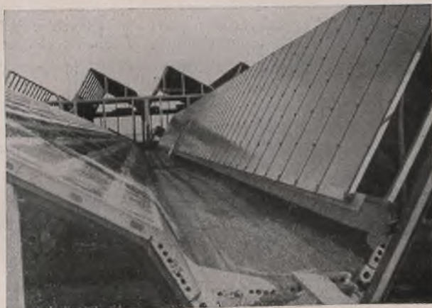
Bild 32. Dacheindeckung und Ausbildung der Rinne.
