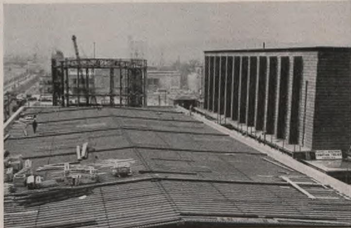
Bild 5. Blick auf das Dach der Längshalle.
