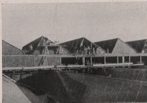
Bild 33. Ausmauern des westlichen Abschlusses der Sägedächer.
