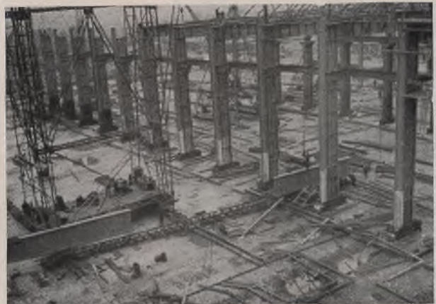
Bild 20. Zusammenbau des Binders.
