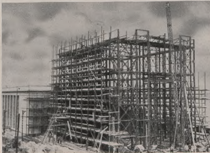
Bild 6. Aufstellung der Stahlkonstruktion der Ehrenhalle.
