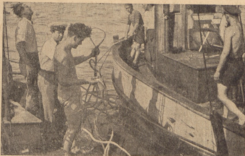
Zaczepty na Zalewie Szczecińskim stanowią niebezpieczną przeszkodę w czasie trawienia włókien. Na zdjęciu kutry spółdzielni „Certa” przy wyciąganiu włoka zaczeptego o wrak.
