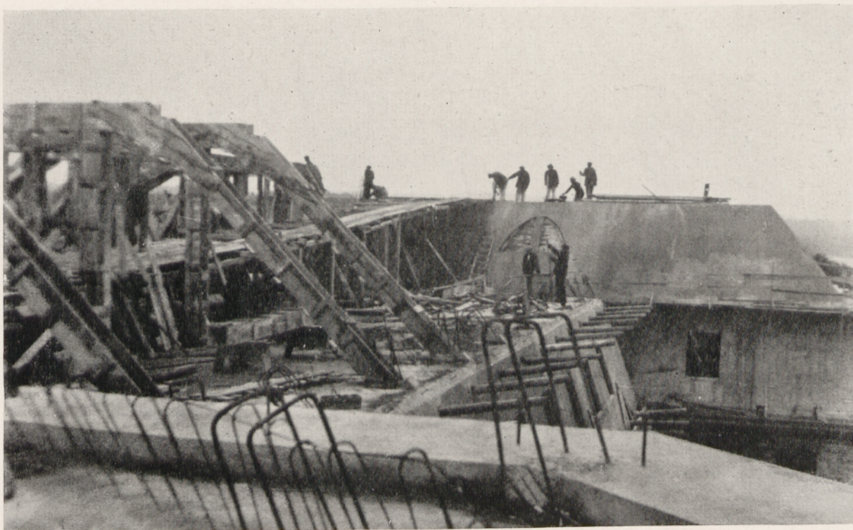
Abb. 17. Eisenbetonkonstruktion am Kasinohotel in Zoppot im Bau
