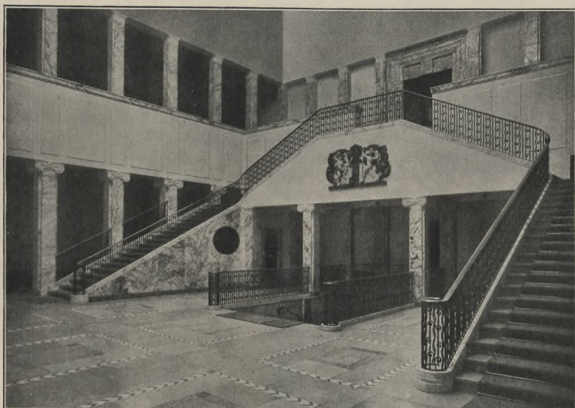
Große Halle mit der Freitreppe (Taf. 42-43.) Biebrich a. Rh. Sektkellerei Henkell & Co.
