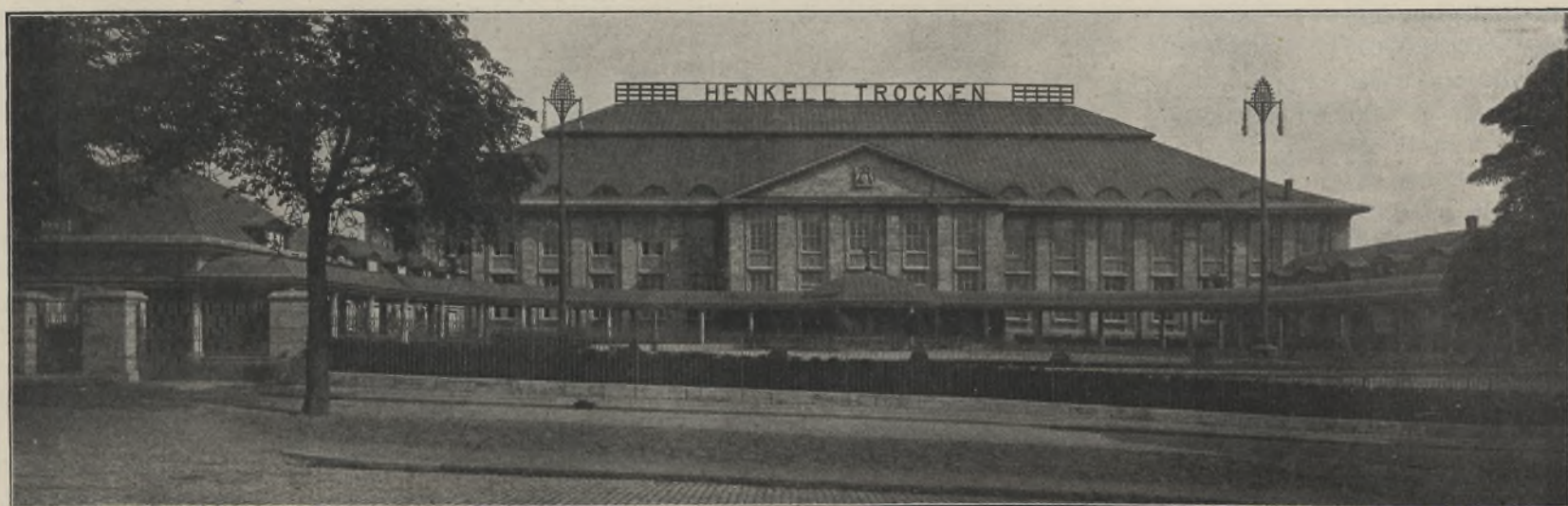
Gesamtansicht (Taf. 42-43.) Biebrich a. Rh. Sektkellerei Henkell & Co.
