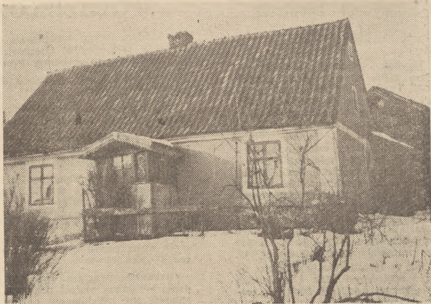
W pow. Reszel czekają na osiedleńców wyremontowane budynki mieszkalne i zabudowania gospodarskie
