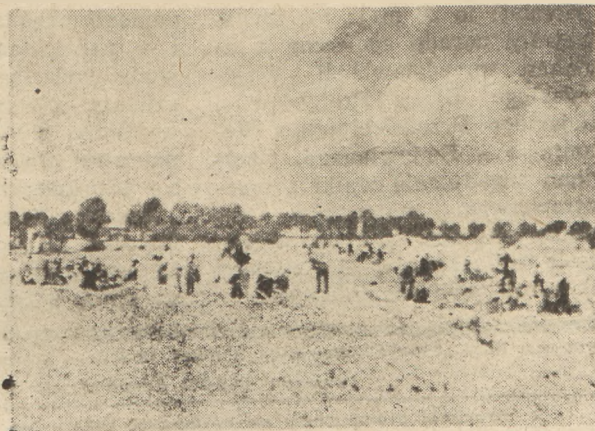
Prace przy kanale Sitno
