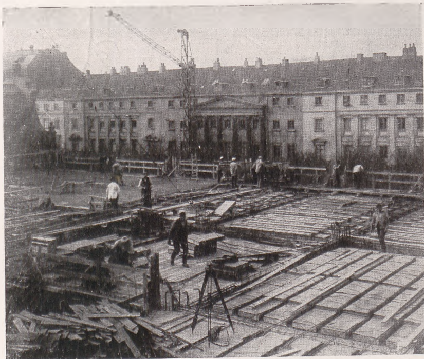
Esplanadehaus Hamburg. Rahmendezellen im Bau.
