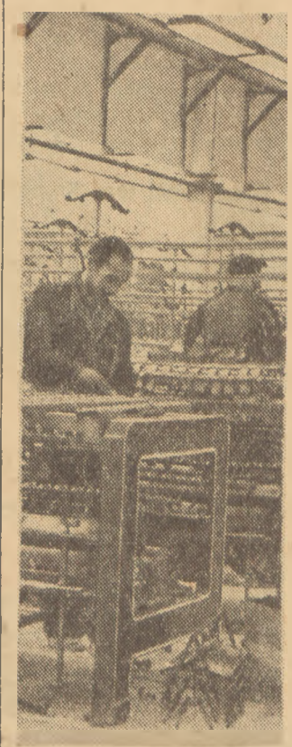
W nowej przedsalni przy Zakładach Przemysłu Bawełnianego im. Armii Ludowej w Łodzi przystąpiono do montażu maszyn przedświątecznych. W najbliższym czasie pierwsze kilogramy przędzy opuszcza nowa przedsalnia.
