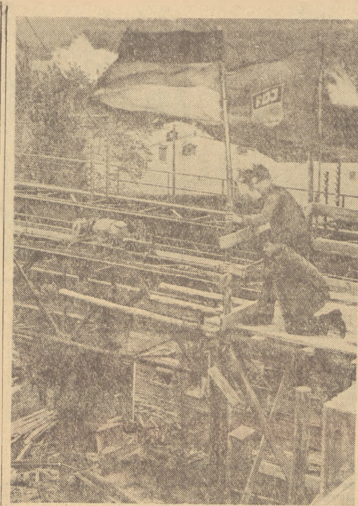
Młodzieżowa brygada przy zakładaniu rusztowań w Trattendorfu.
