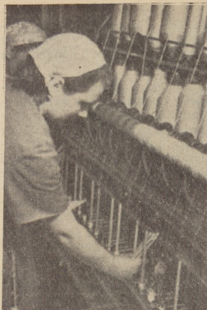
19. Trzecia obciążaczka rozpoczyna natykanie cewek lewą ręką na 2 wrzeciono, prawą na 5 wrzeciono itd. zostawiając jedno wolne.
