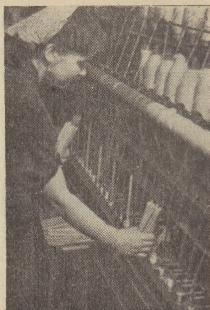
18. Prawą ręką natyka cewki na wrzeciona dwunaste, osiemnaste, dwudzieste czwarte itd., na co trzecie wrzeciono.
