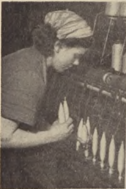
7. Lewą ręką chwyta kopkę z 5 wrzeciona pomiędzy pale wskazującym a pozostałymi trzema.
