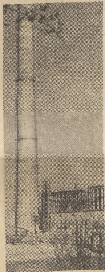
Pod koniec bieżącego roku uruchomiony zostanie pierwszy turbozespol elektrowni w Ostrołęce. Na zdjęciu: fragment budowy elektrowni. Foto: CAF
