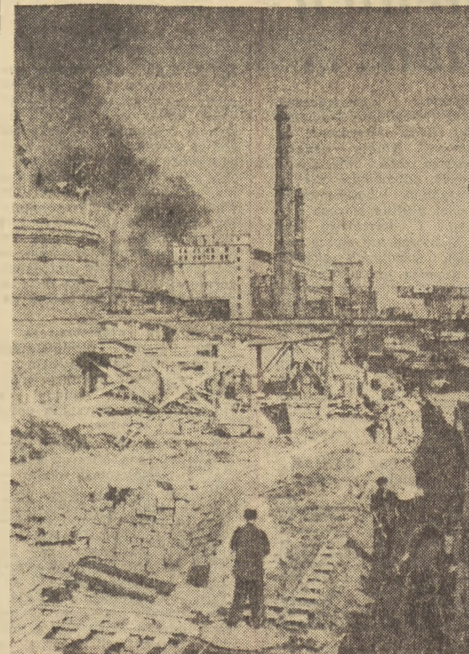
W rejonie kokschemi prowadzone są prace przy budowie 1 i 2 baterii koksowniczych w Nowej Hucie. Na zdjęciu: fragment rejonu budo w tych baterii. Foto CAF
