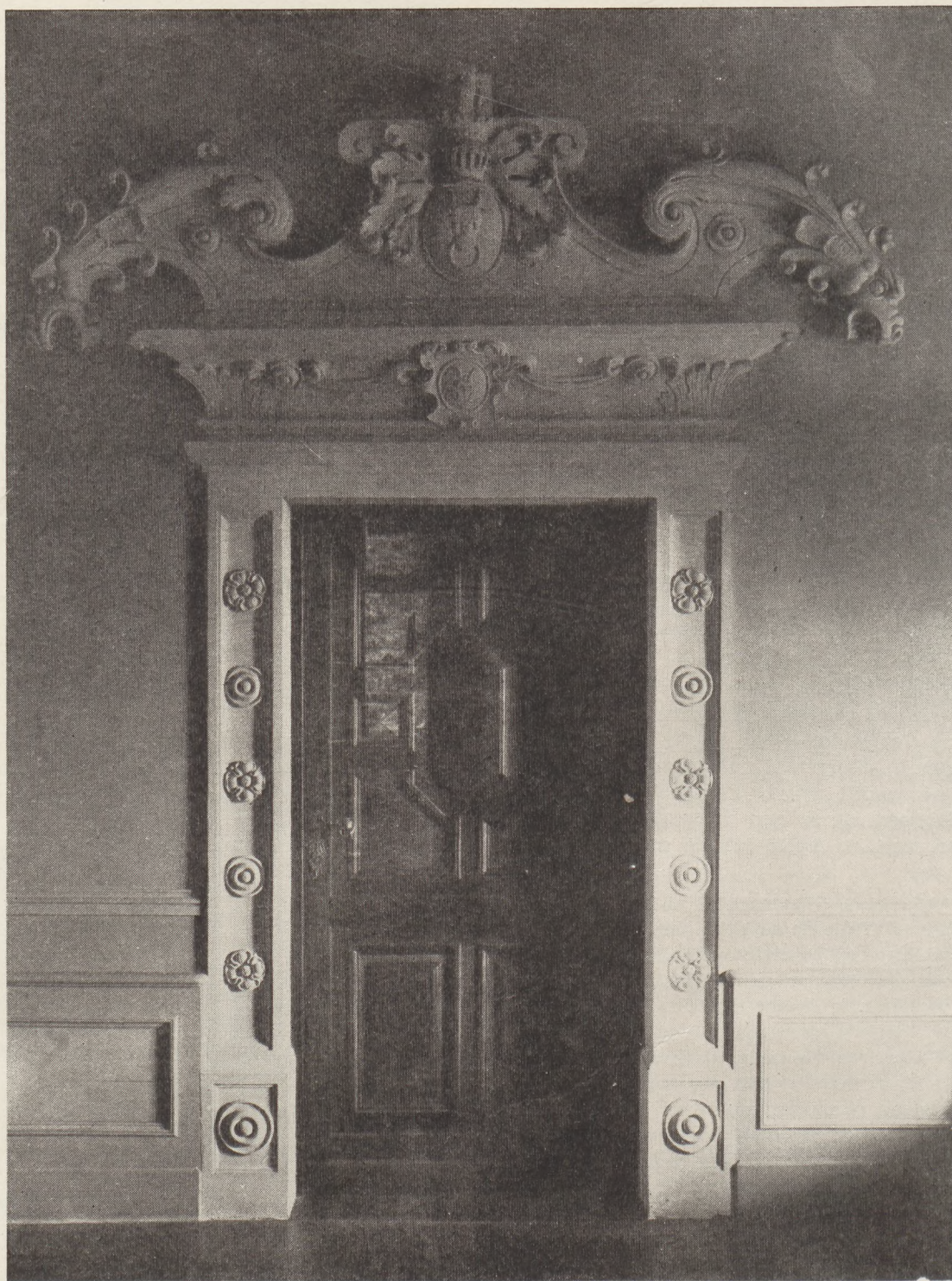
Ryc. 39. Portal w zamku w Baranowie. Ok. 1600. (Fot. I. Krieger).
