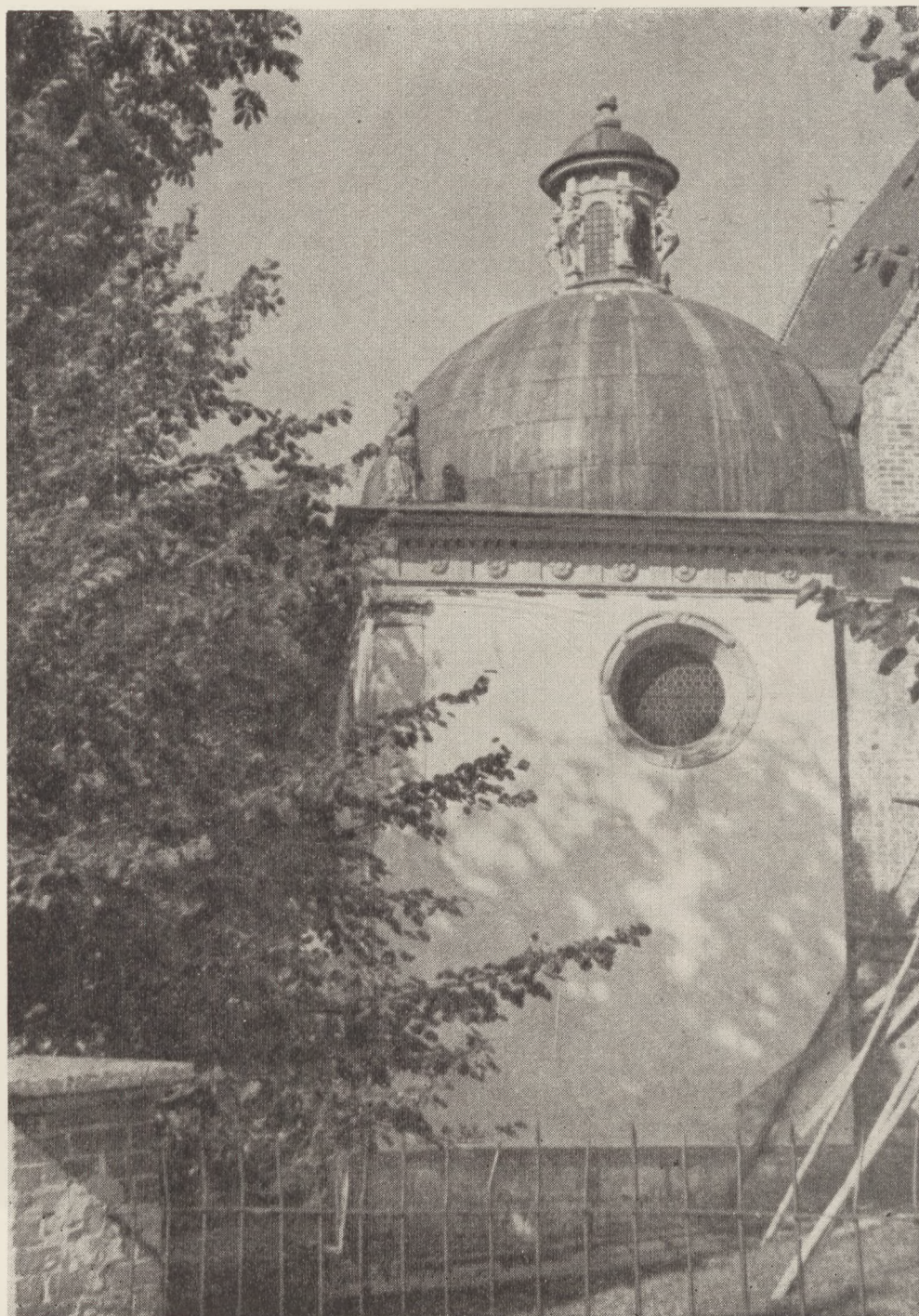
Ryc. 41. Widok zewnętrzny kaplicy Firlejów przy kościele parafialnym w Bejskach Ok. 1600. (Fot. J. Łoziński).
