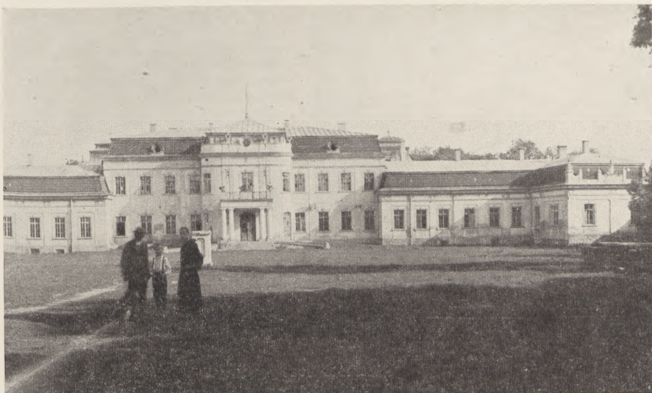
Ryc. 16. Pałac w Krystynopolu, elewacja od strony dziedzińca.
