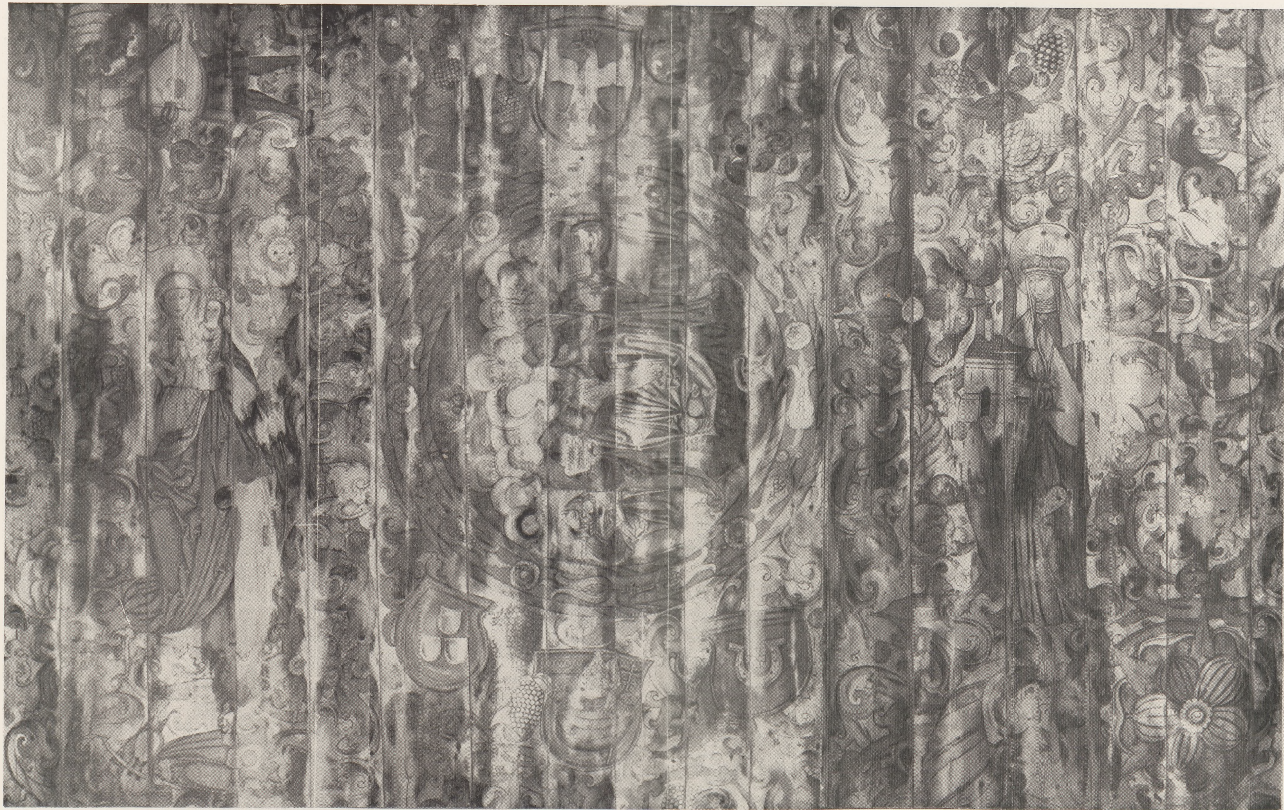
Ryc. 6. Grębień, polichromia stropu nawy. (Fot. E. Kozłowska).
