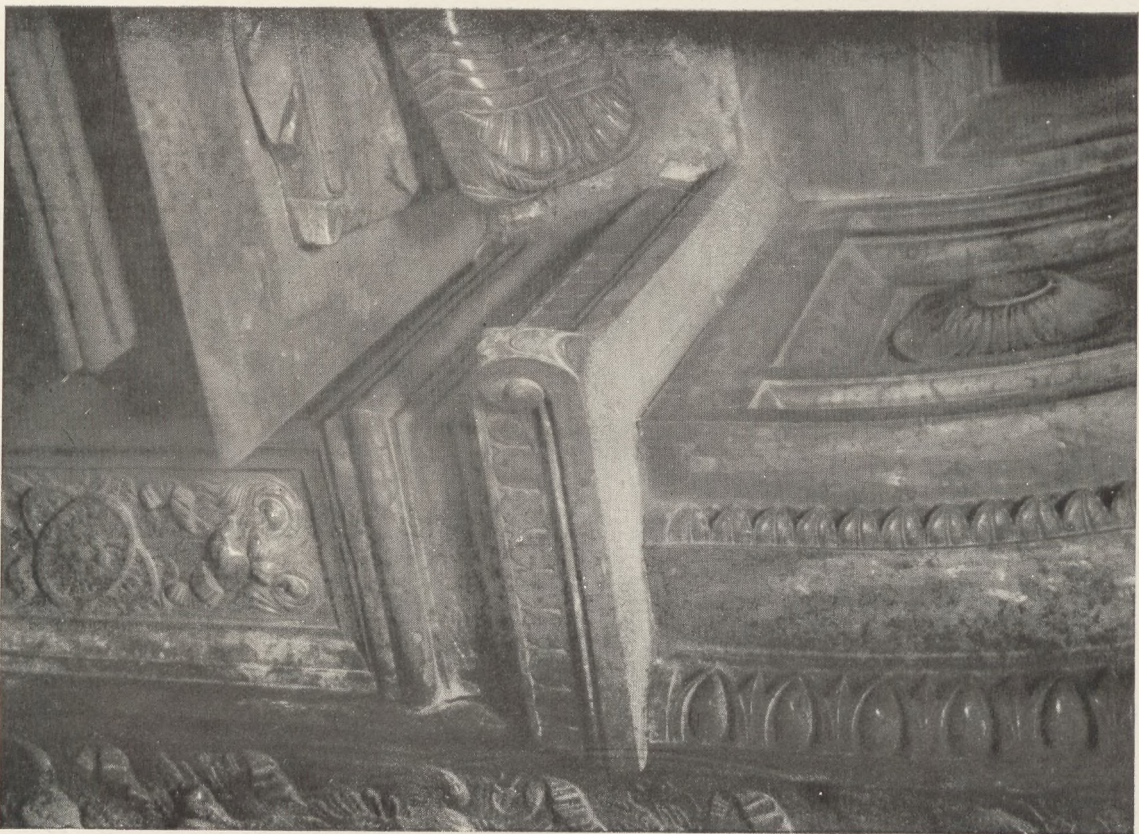
Ryc. 5. Pierwotny gzyms przekuty w kapitel w arkadzie z nagrobkami królewskimi. (Fot. R. Kozłowski).
