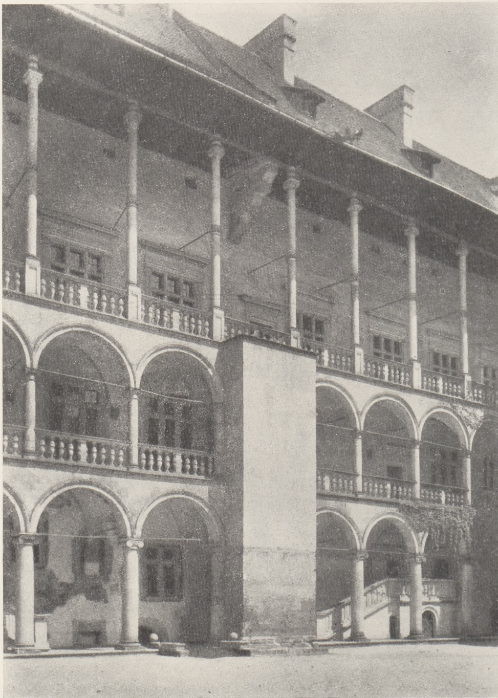
Ryc. 5. Fragment krużganków skrzydła północnego; po lewej stronie na parterze odsłonięty mur gotycki, po środku filar szkarpowy. (Fot. S. Kolowca).
