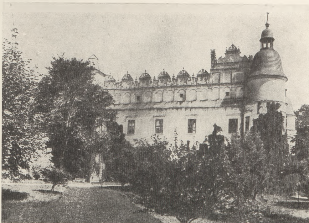
Ryc. 3. Zamek w Baranowie, fragment elewacji południowej, stan z ok. r. 1915. (Fot. S. Rakowski).
