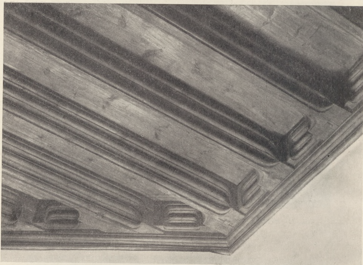
Ryc. 19. Strop belkowany na parterze. (Fot. S. Kolowca).
