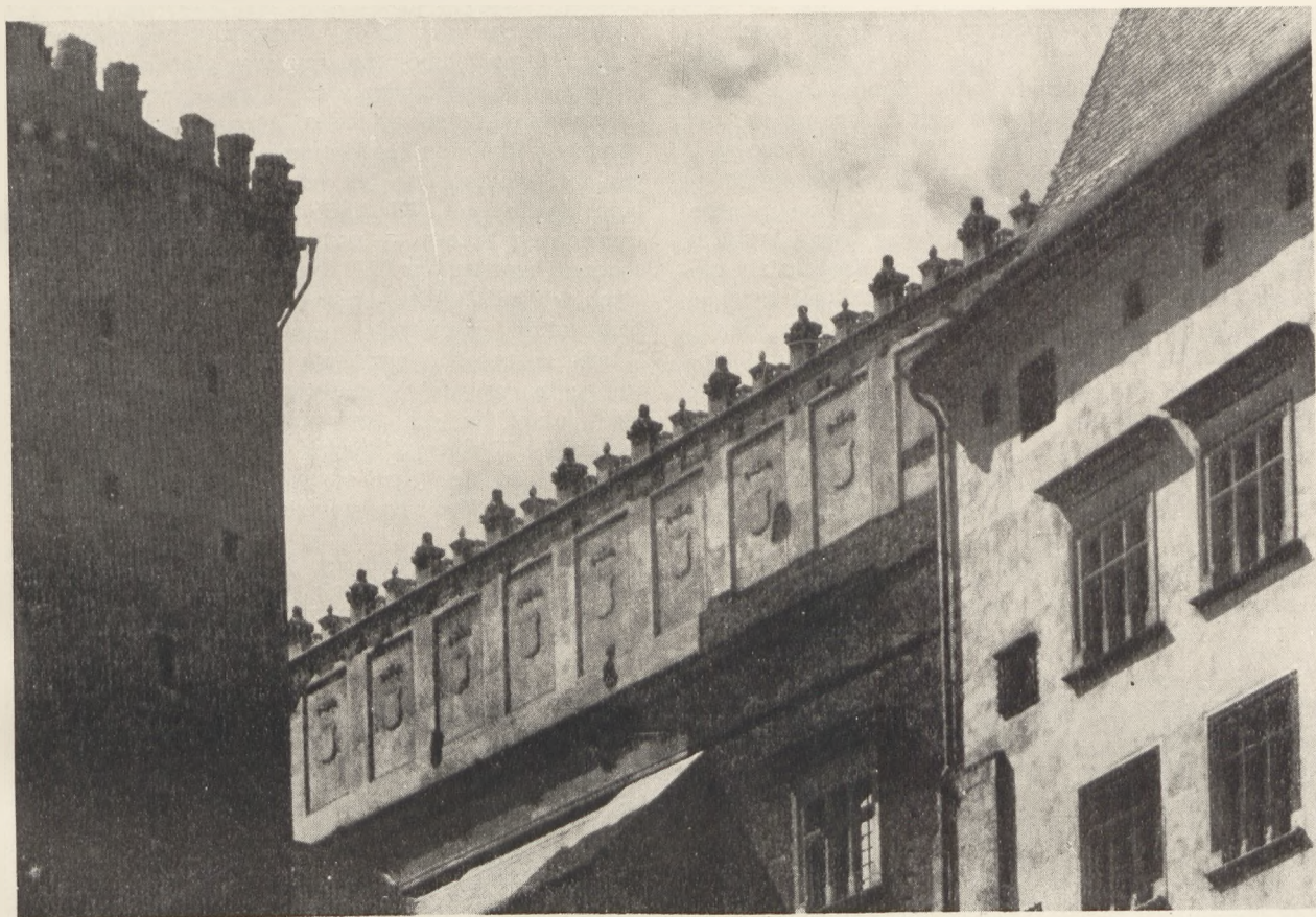
Ryc. 10. Attyka skrzydła południowego. (Fot. S. Kolowca).
