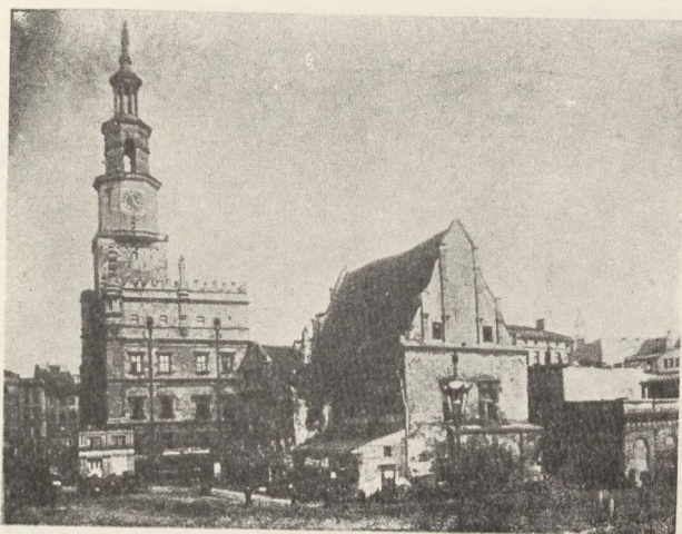
Ryc. 2. Ratusz poznański od strony zachodniej i budynki Wagi miejskiej, rozebrany w roku 1895.
