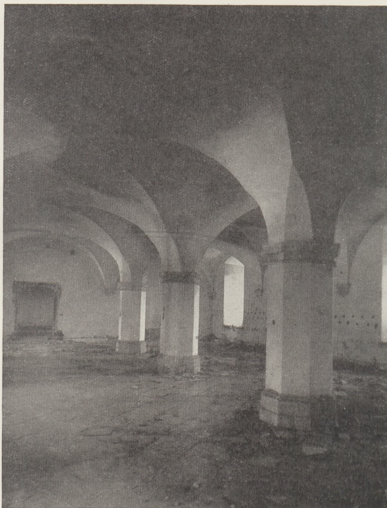
Il. 15. Sala w przyziemiu skrzydła pd., stan z r. 1939.
