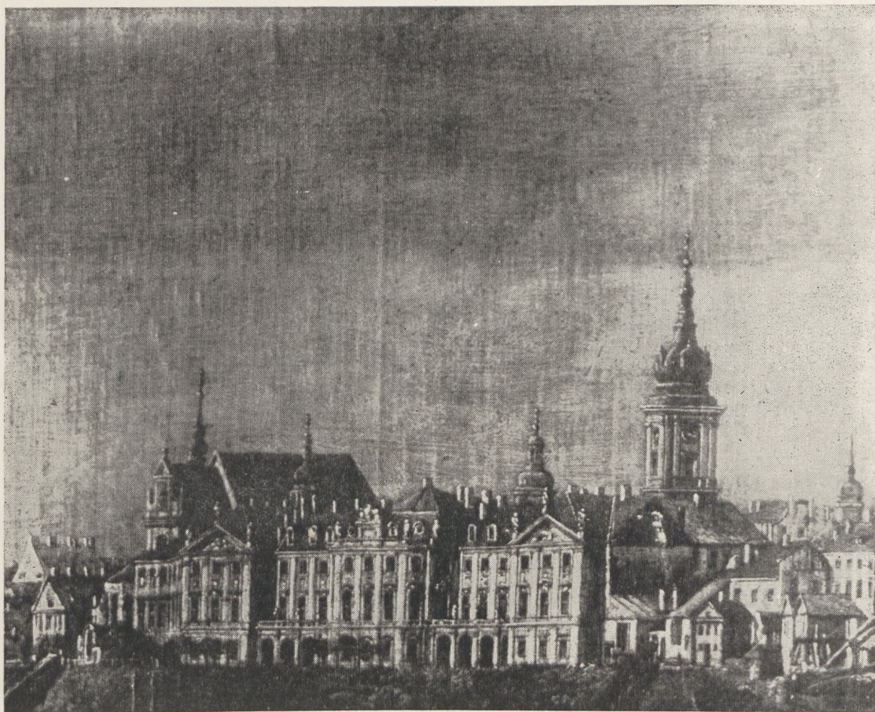
I. 12. Elewacja wsch., fragment obrazu Canaletta „Widok Warszawy od strony Pragi”. (Fot. S. Jaworski)
