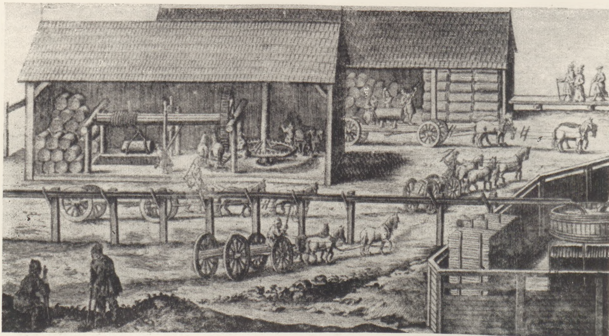
Il. 17. Część lewa ilustracji na planszy czwartej: powierzchnia kopalni. (Fot. B. Stabiński)
