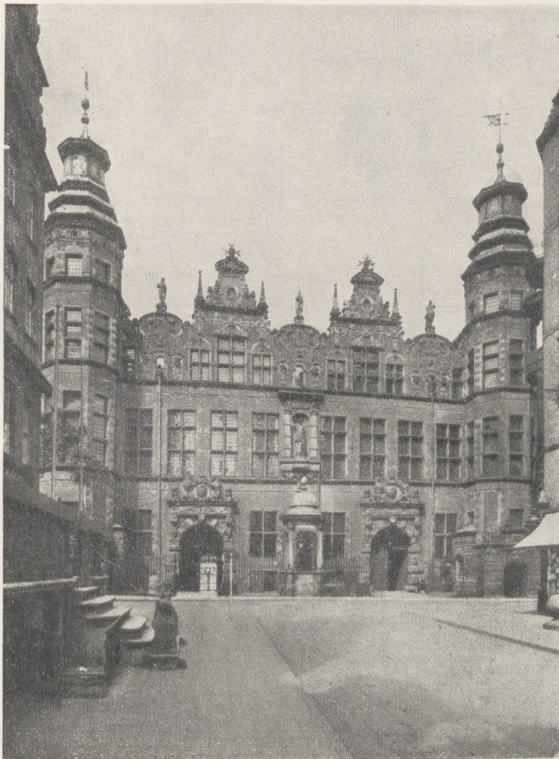
Il. 6. Arsenal, fasada. (Fot. sprzed r. 1945)
