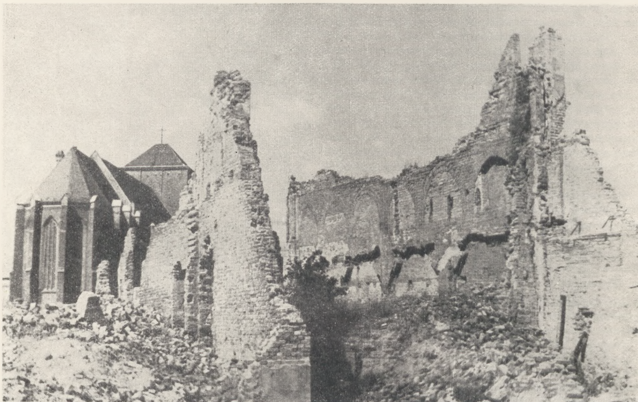
Il. 13. Ruiny domu gotyckiego przy ul. Długiej. (Fot. Z. Świechowski)
