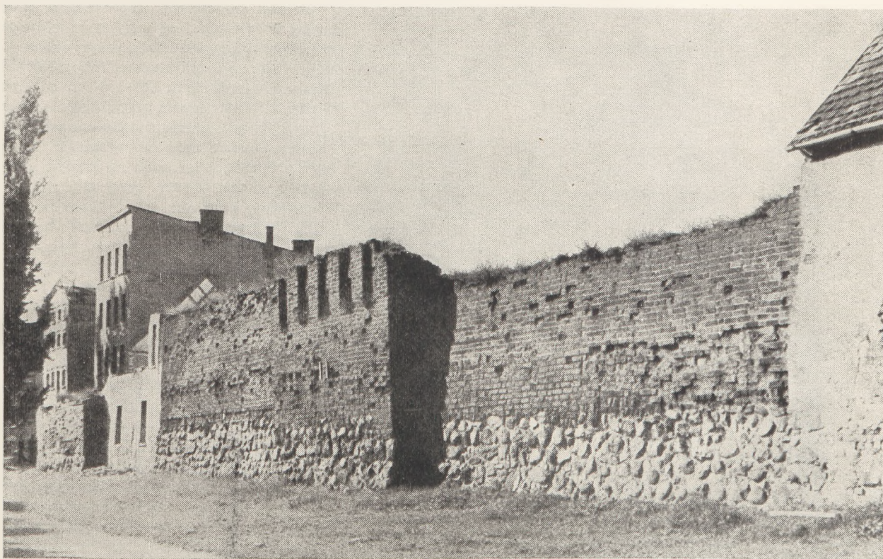
Il. 8. Mury obronne między ul. Akacjową i Dominikańską. (Fot. Z. Świechowski)
