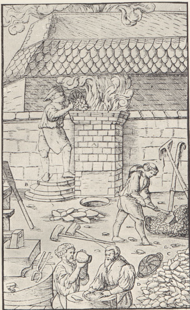
Il. 24. Piec do wytapiania żelaza, drzeworyt z dzieła Agricoli.
