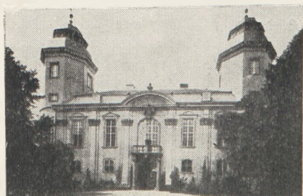
Il. 2. Biblioteka zamkowa w Książu k. Wałbrzycha, fasada
