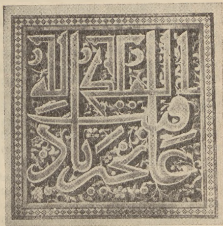
Mauzoleum Gūr-i-mīr. Fragment drzwi
