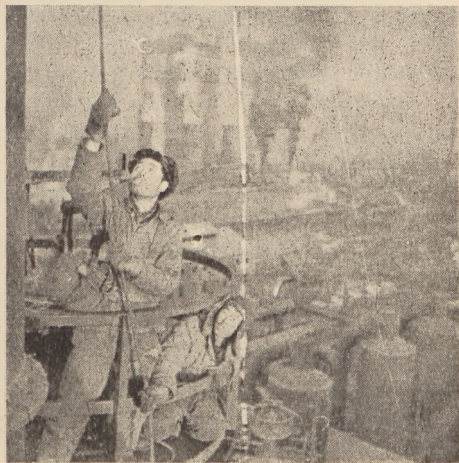
Budowa wielkiego pieca w anszańskim kombinacie metalurgicznym
