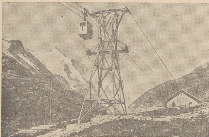
Rys. 2. Towarowo-osobowa kolej linowa o ruchu okrężnym w Heiligblut na Margaritze (Austria).
