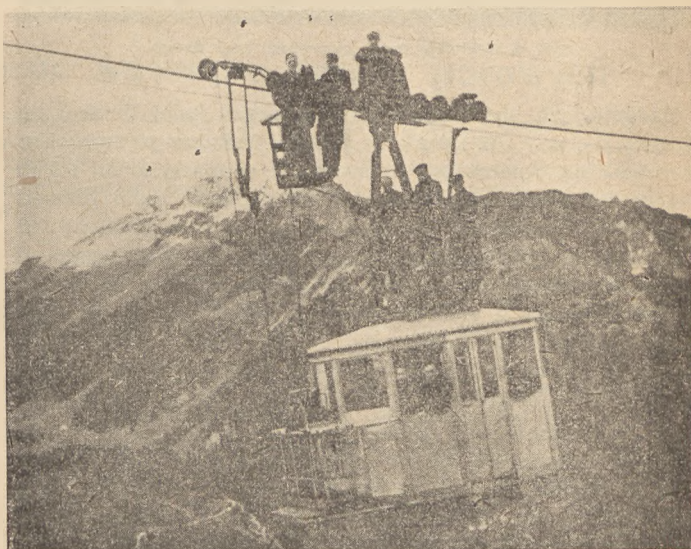
Rys. 5. Badanie liny nośnej kolei linowej na Kasprowy Wierch. Na linie przed wózkem wagonika rolki elektromagnesu. Aparat mieści się w wagoniku.
