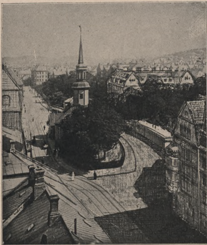
Abb. 40. Anordnung einer doppelarmigen Verkehrsstraße, um den Abbruch der alten Holzkirche aus verkehrstechnischen Gründen zu verhindern.
