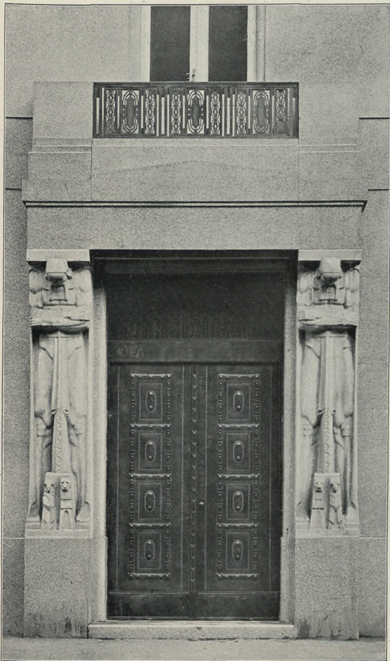
Portal des Palais des Wiener Bankvereines in Prag. Architekt k. k. Baurat J. Zásche in Prag und Architekt A. Neumann in Wien.
