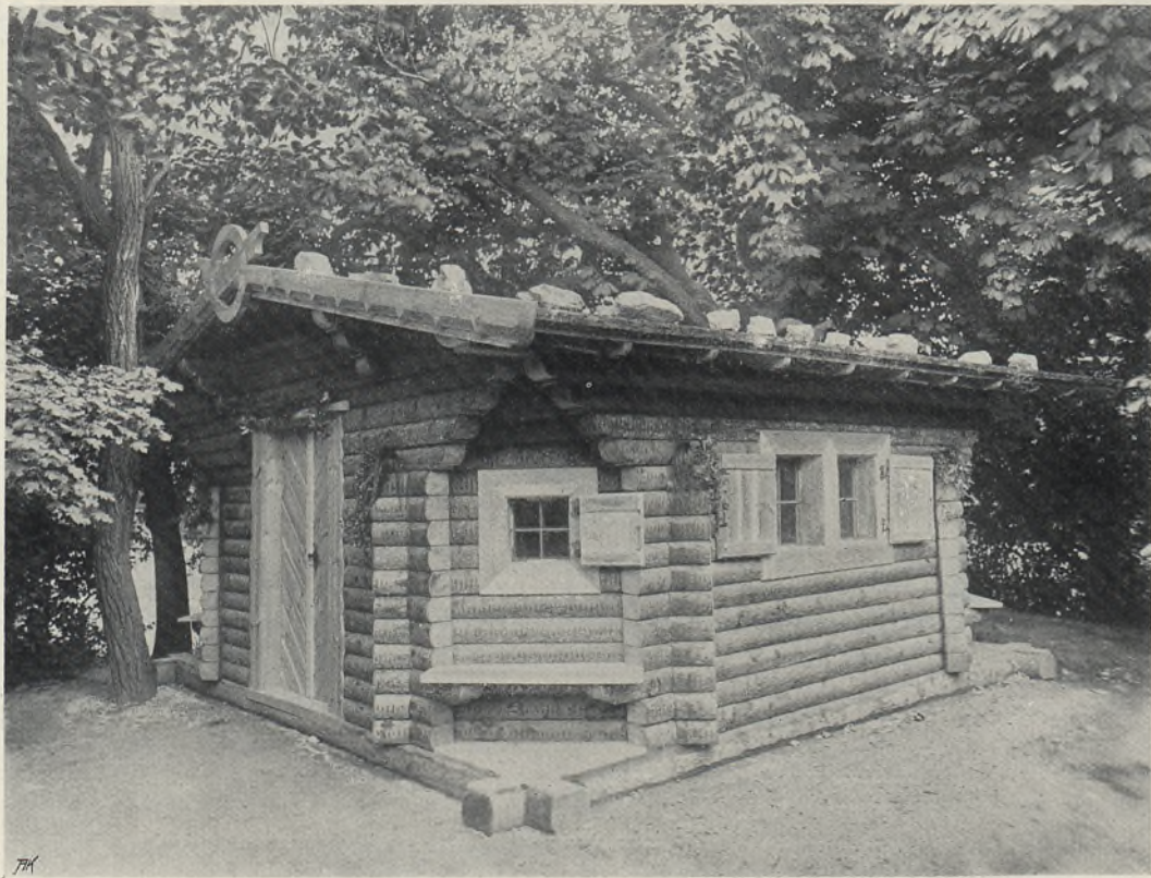
Brunnenhaus im Schlosse Datschitz. Architekt Hans Prutscher.
