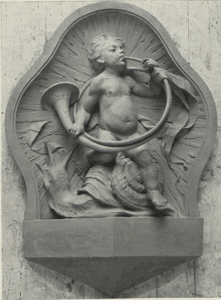
Füllung aus dem Posthof in Wiener-Neustadt. Von den Architekten Theiß und Jaksch. Ausführung von Jung, Ruß & Cie., Wien.
