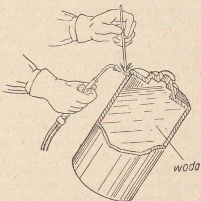
Rys. 2. Spawanie zbiornika napełnionego wodą.
