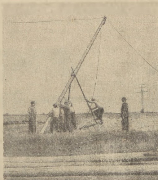
Rys. 2. Początek budowy wieży (foto inż. Jarosiński)
