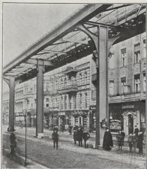
Abb. 119: Probeversuch einer Schwebebahn in der Brunnenstraße in Berlin N. von Bruno Möhring, Alfred Grenander und Sepp Kaiser.
