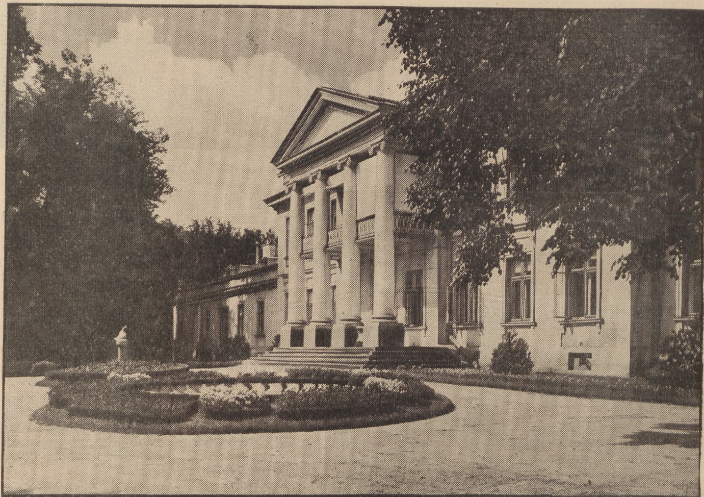
Widok na Pałac Belwederski od strony parku.
